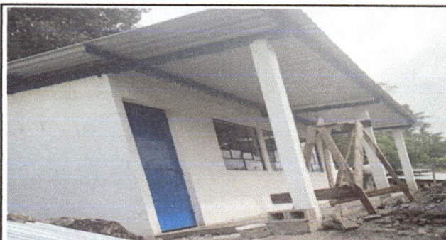
Foto 6: Paredes de concreto de columnas de corredor y esquineras.
