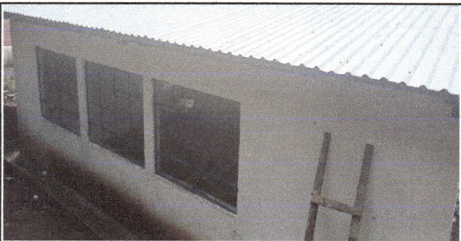
Foto 5: Ventanas de metal con vidrios
