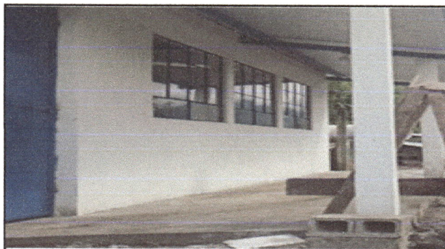
Foto 4: Piso de concreto alisado dentro y fuera del aula.
