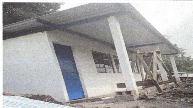
Foto 2: paredes y columnas fundidas.
