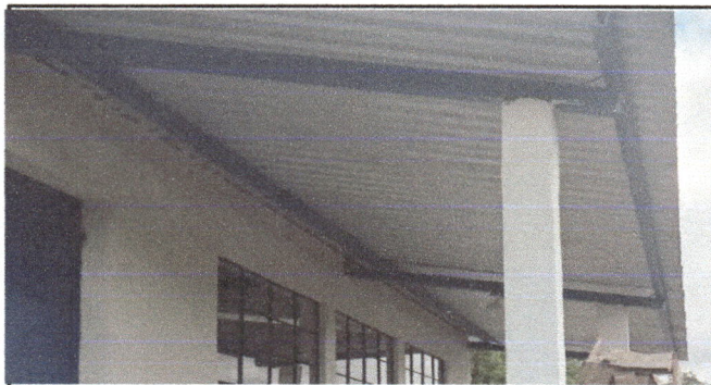
Foto 3: Instalación portante de techo.
